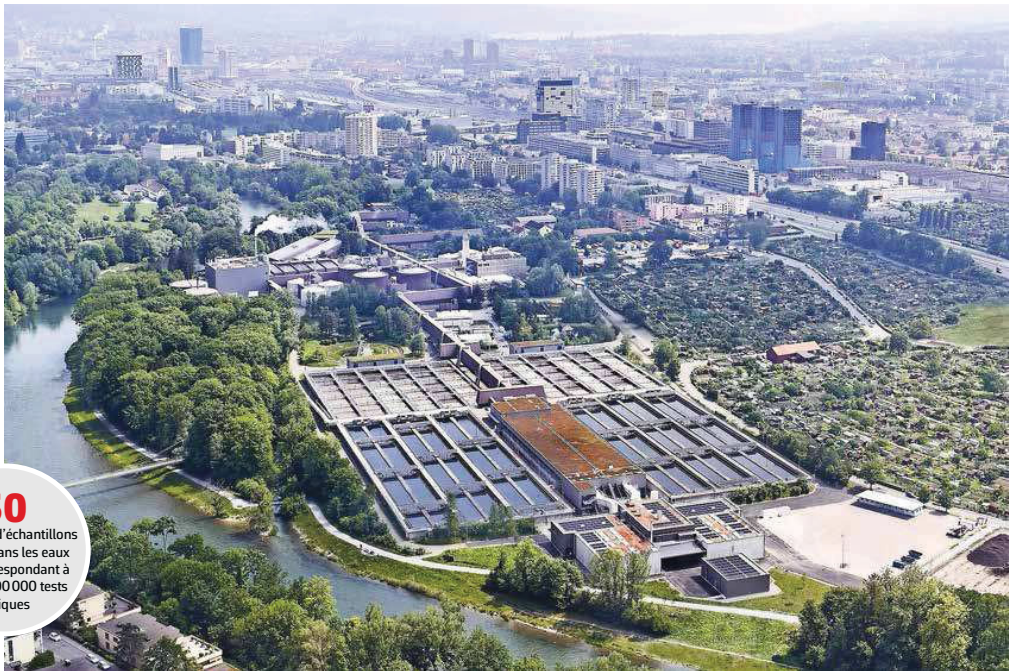
La station d'épuration des eaux usées de Zurich (photo) fait partie, avec celle de Lausanne, des deux STEP donnant des renseignements sur l'évolution de la pandémie. DR
